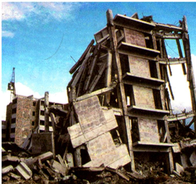
Железобетонный каркас спроектирован с учетом сейсмических нагрузок и соответствующих среднему уровню ASD; но следует принимать класс уязвимости В: недостаточная пространственная связь между балками и колоннами; серьезные дефекты в строительстве; как при производстве работ, так и по качеству и прочности материалов; недооценка (снижение) сейсмической опасности и значений сейсмических нагрузок.
