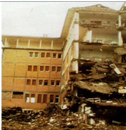
Незаконченная больница со средним уровнем ASD (ускорение основания принято 0,07g в соответствии со строительными нормами); Г – образная (неправильная) в плане форма предлагает более низкий класс уязвимости.
